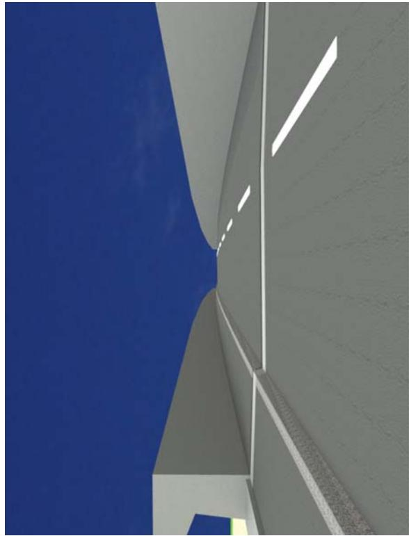
图 5.1 暴风雪时的走行安全性の向上を目的とした橋（下路桁橋）
