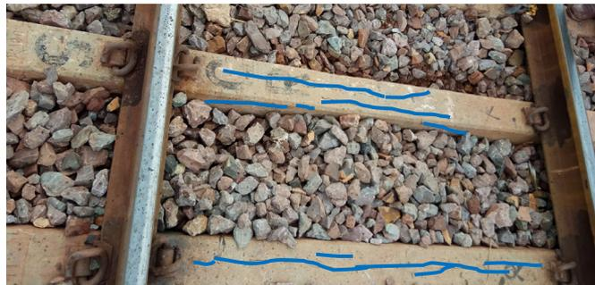
中央部: 軸方向のひび割れ
