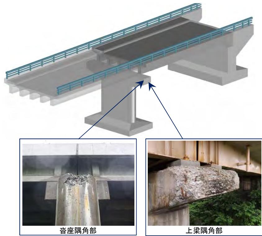
図 4.3.6 道路橋の凍害による劣化事例(6/8) 橋脚①
