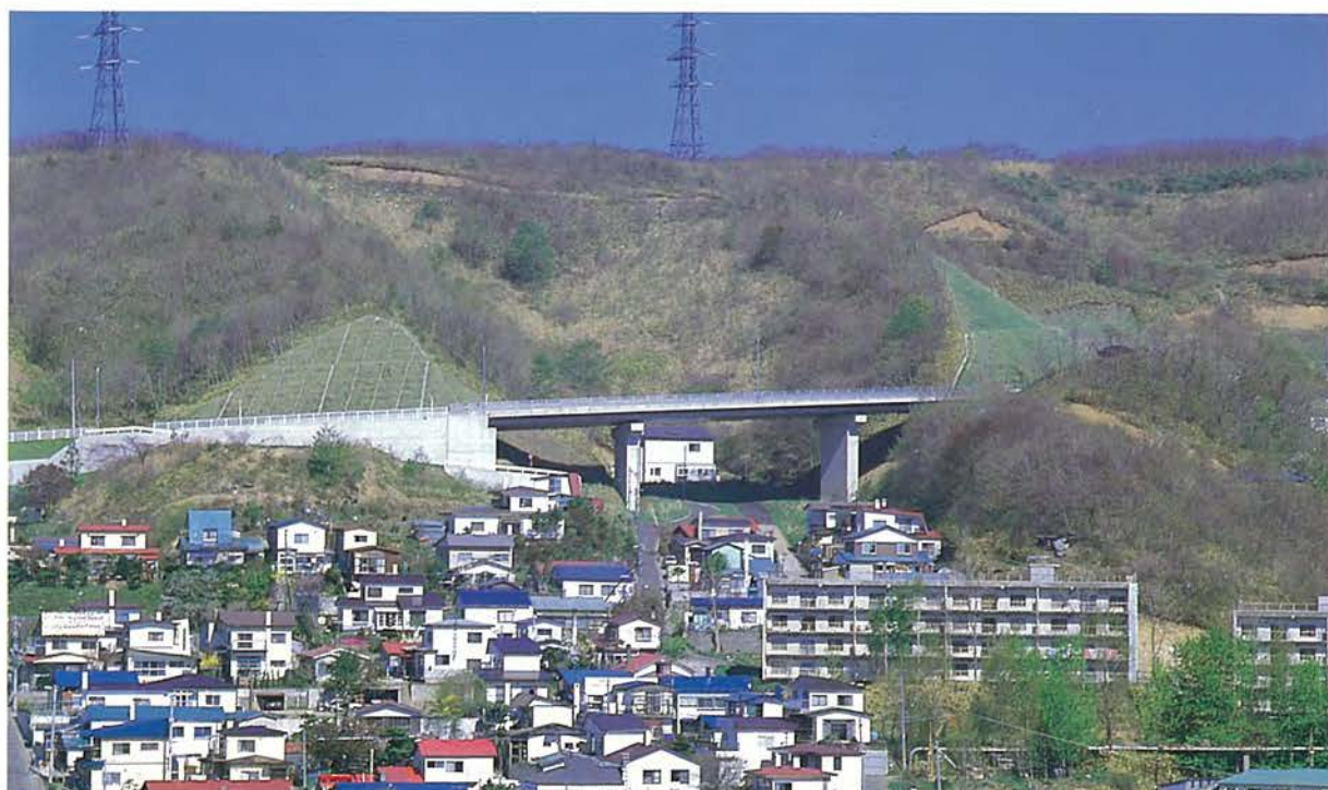
所在地：室蘭市，橋長：71.00 m，支間割：2 @ 19.00 + 32.00 m，幅員：11.00 + 2.50 m，型式：2 径間連続中空床版・単純中空床 版，工法：フレッシュ工法，企業者：室蘭土木現業所，施工者：ドービー建設工業，竣功年：昭和 59 年
