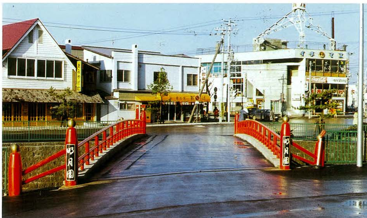
所在地：函館市，橋長：17.50 m，幅員：4.60 m，型式：単純中空床版，工法：プレテン，企業者：函館土木現業所， 施工者：北海道ピーエスコンクリート，竣功年：昭和 53 年
