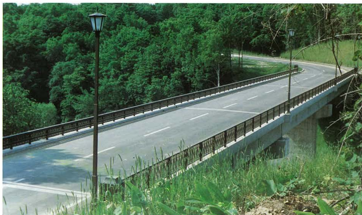
所在地：札幌市，橋長：104.00 m，支間割：3 @ 33.90 m，幅員：10.50 m，型式：単純 T 桁，工法：フレシネー工法， 企業者：道森林公園，施工者：北海道ビーエスコンクリート・北炭 JV，竣功年：昭和 56 年
