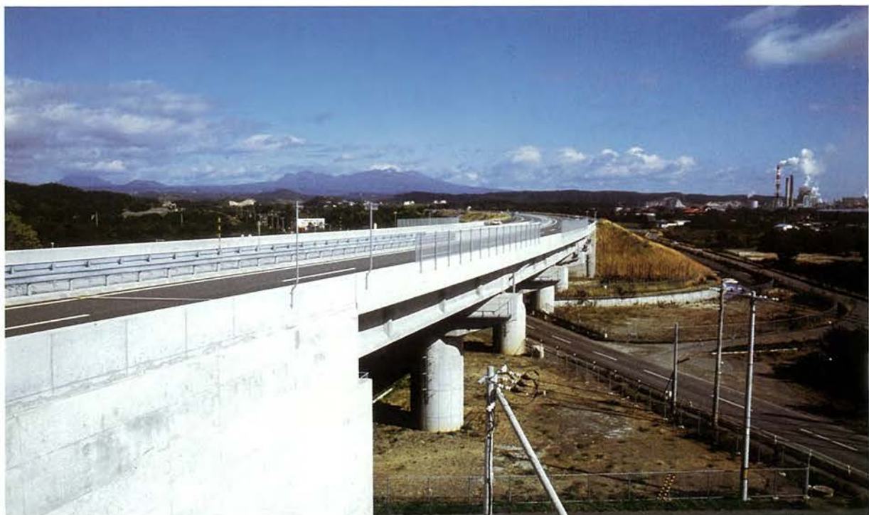
所在地：白老町，橋長：144.30 m，支間割：5 @ 28.54 m，幅員：10.00 m × 2，型式：5 径間連続合成桁，工法：フレッシュー工法， 企業者：日本道路公団，施工者：日本高圧コンクリート，竣工年：昭和 60 年
