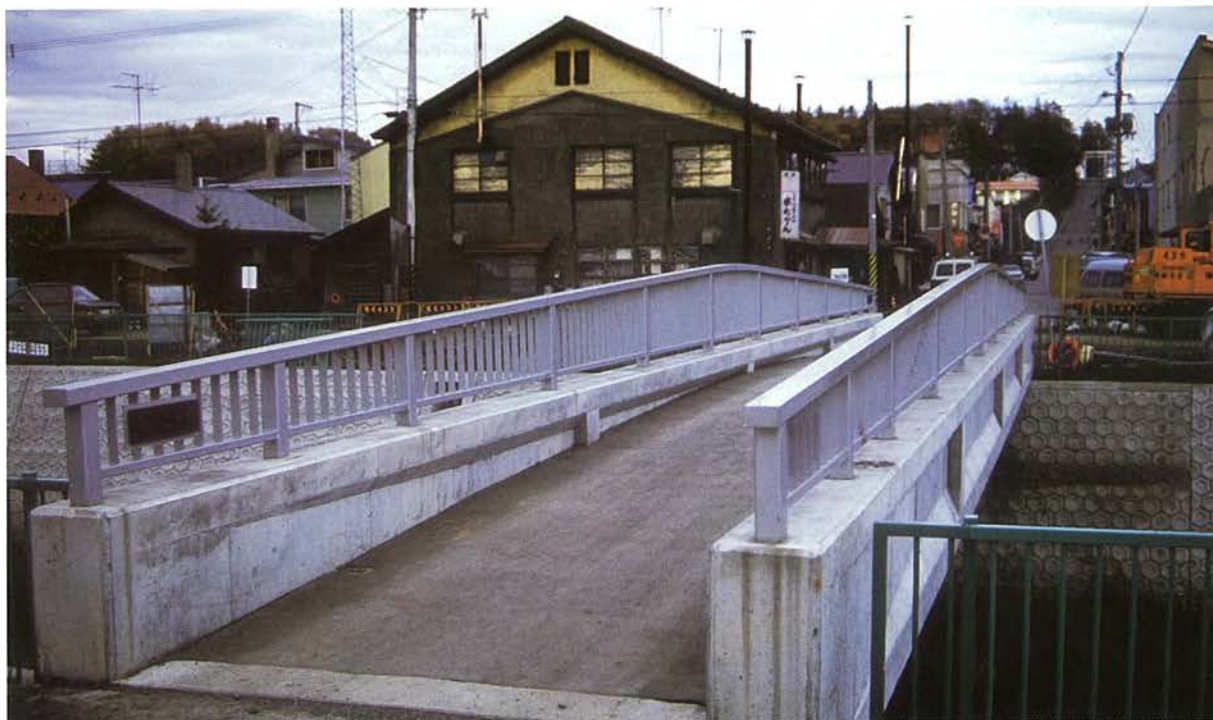
所在地：追分町，橋長：24.00 m，幅員：2.50 m，型式：単純中路桁，工法：フレシネー工法，企業者：追分町， 施工者：日本高圧・八木 JV，竣功年：昭和 58 年
