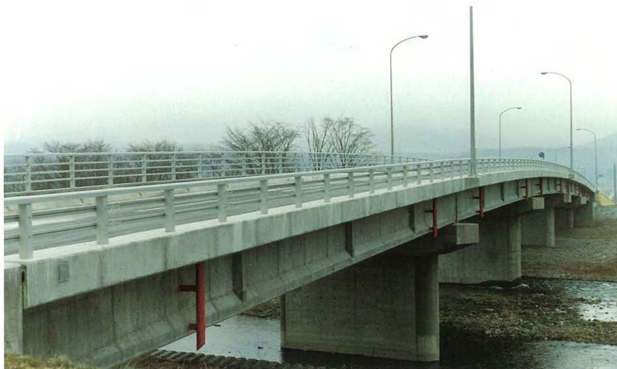
所在地：訓子府町，橋長：158.20 m，支間割：5 @ 30.98 m，幅員：7.50 + 2.50 m，型式：単純 T 桁，工法：BBRV 工法， 企業者：網走土木現業所，施工者：北海道ビーエスコンクリート，竣功年：昭和 53 年
