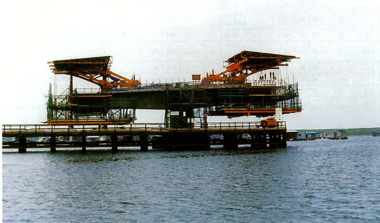
所在地：常呂町，橋長：286.80 m，支間割：(2@25.80 + 25.20) × 2 + 35.00 + 60.00 + 35.00 m，幅員：7.50 + 1.50 m 型式：3径間連続合成桁・3径間連続変断面箱桁，工法：フレシネー・D&W工法，企業者：網走土木現業所， 施工者：ドービー・鹿島・住友JV
