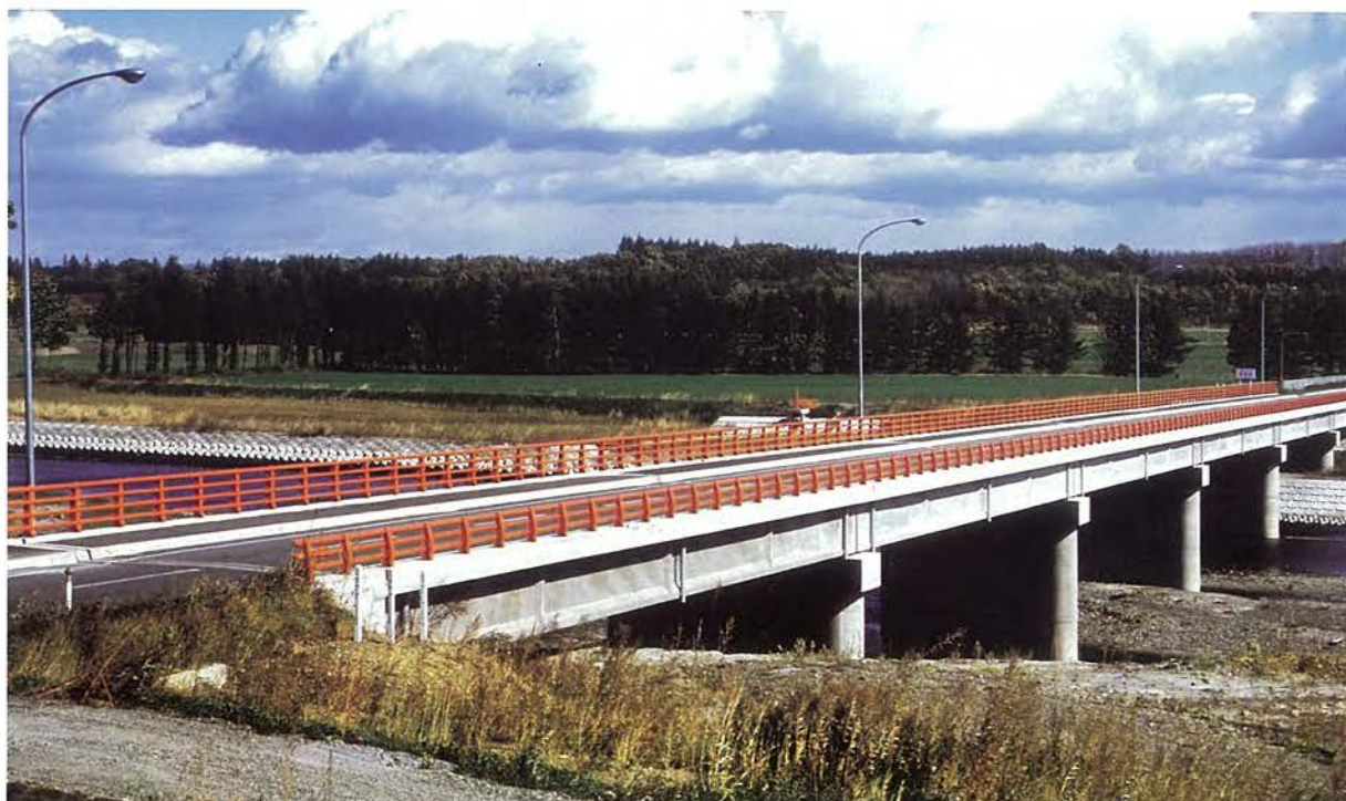
所在地：音更町，橋長：234.10 m，支間割：6 @ 38.00 m，幅員：7.50 + 2.00 m，型式：単純 T 桁，工法：フレシネー工法，企業者：音更町，施工者：日本高圧コンクリート，竣工年：昭和 60 年
