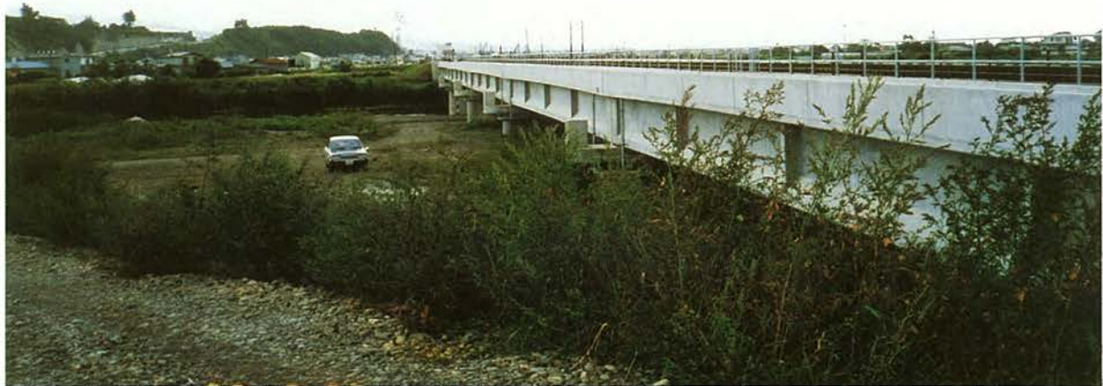
所在地：伊達市，橋長：195.00 m，支間割：5 @ 39.00 m，幅員：3.80 m，型式：単純 T 桁，工法：フレッシュー工法， 企業者：札幌工事局，施工者：ピースコンクリート，竣工年：昭和 60 年
