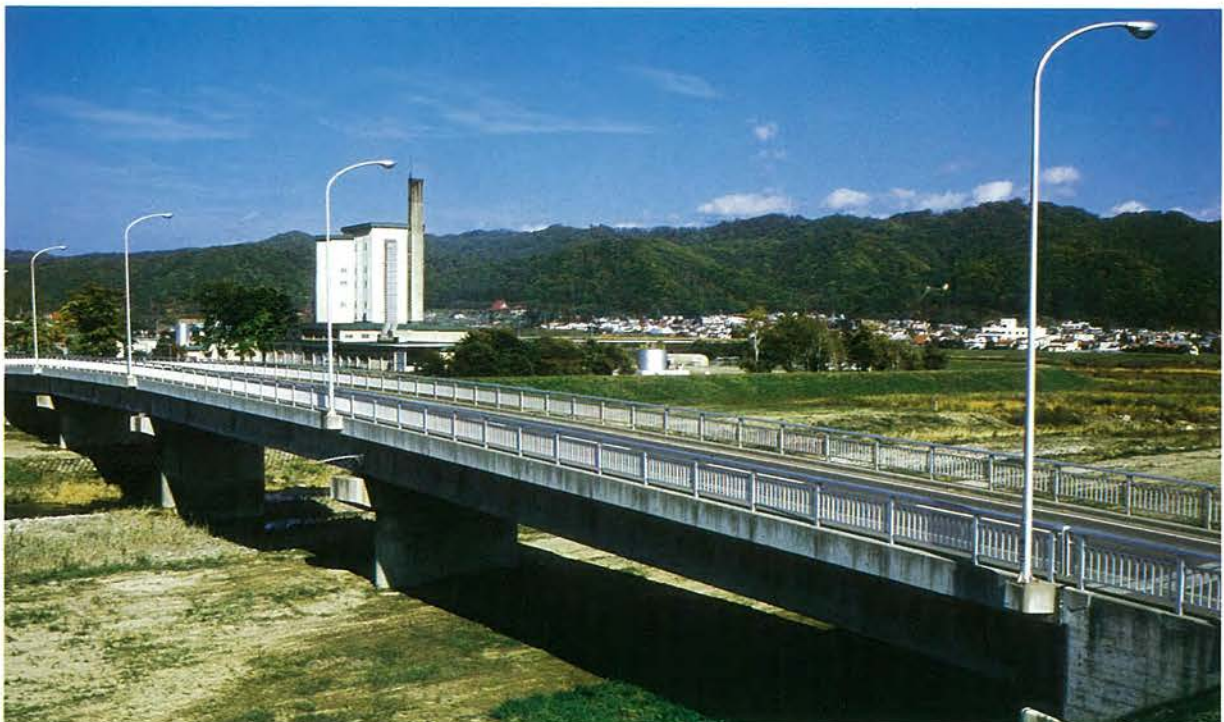
所在地：本別町，橋長：152.00 m，支間割：4 @ 37.25 m，幅員：6.75 + 2.25 m，型式：単純 T 桁，工法：フレシネー工法， 企業者：帯広土木現業所，施工者：日本高圧コンクリート，竣功年：昭和 50 年
