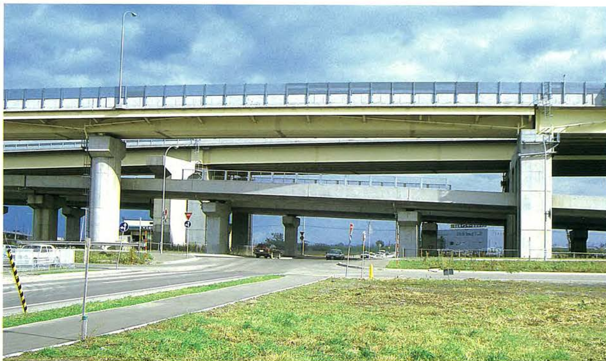
所在地：札幌市，橋長：63.60 m，支間割：3 @ 21.00 m，幅員：8.00 m × 2，型式：3 径間連続中空床版，工法：フレシネー工法， 企業者：札幌開発建設部，施工者：日本高圧コンクリート，竣工年：昭和 55 年
