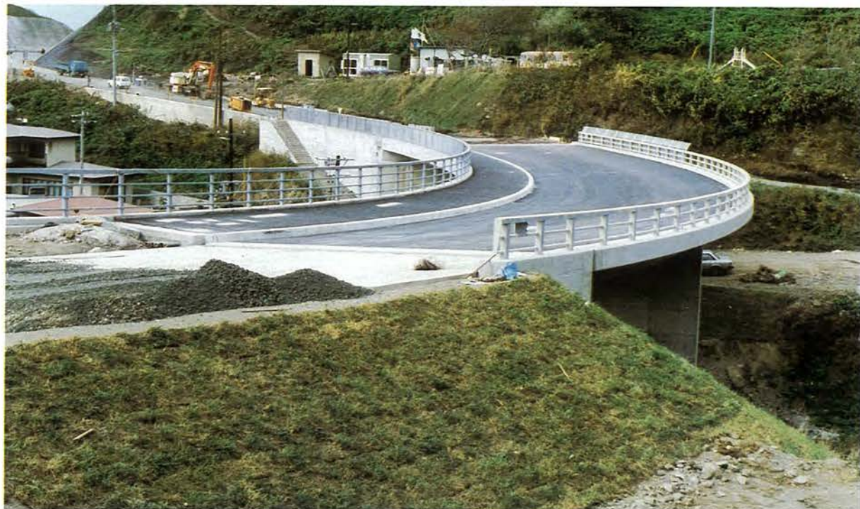
所在地：乙部町，橋長：75.00 m，支間割：3 @ 24.70 m，幅員：8.50 + 3.00 m，型式：3 径間連続中空床版， 工法：フレシネー工法，企業者：函館開発建設部，施工者：日本高圧コンクリート，竣工年：昭和 55 年
