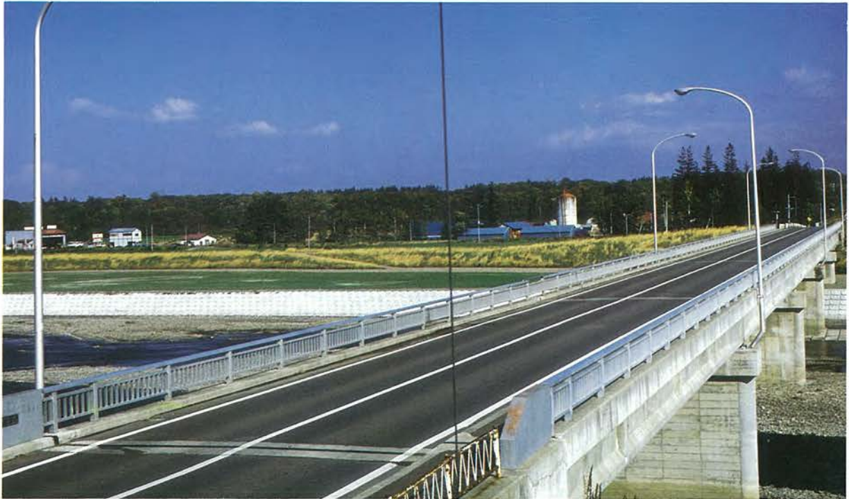
所在地：音更町，橋長：163.00 m，支間割：5 @ 31.80 m，幅員：6.75 + 1.50 m，型式：単純 T 桁，工法：フレシネー工法， 企業者：帯広土木現業所，施工者：日本高圧コンクリート，竣功年：昭和 50 年
