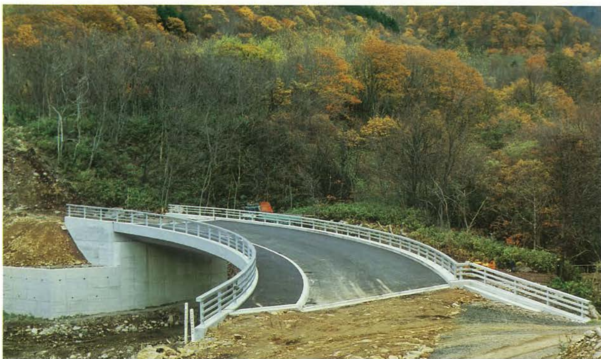
所在地：神恵内村，橋長：46.00 m，支間割：2 @ 22.60 m，幅員：6.50 + 2.50 m，型式：2 径間連続中空床版， 工法：フレシネー工法，企業者：神恵内村，施工者：ドービー・協成 JV，竣功年：昭和 59 年
