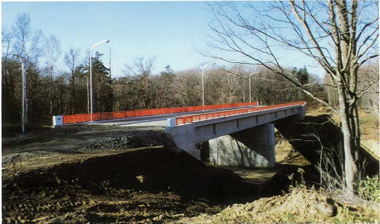
所在地：広島町，橋長：70.00 m，支間割：2 @ 33.90 m，幅員：8.50 + 4.50 m，型式：2 径間連続合成桁，工法：フレッシュ工法， 企業者：広島町，施工者：北海道ビーエスコンクリート，竣工年：昭和 55 年
