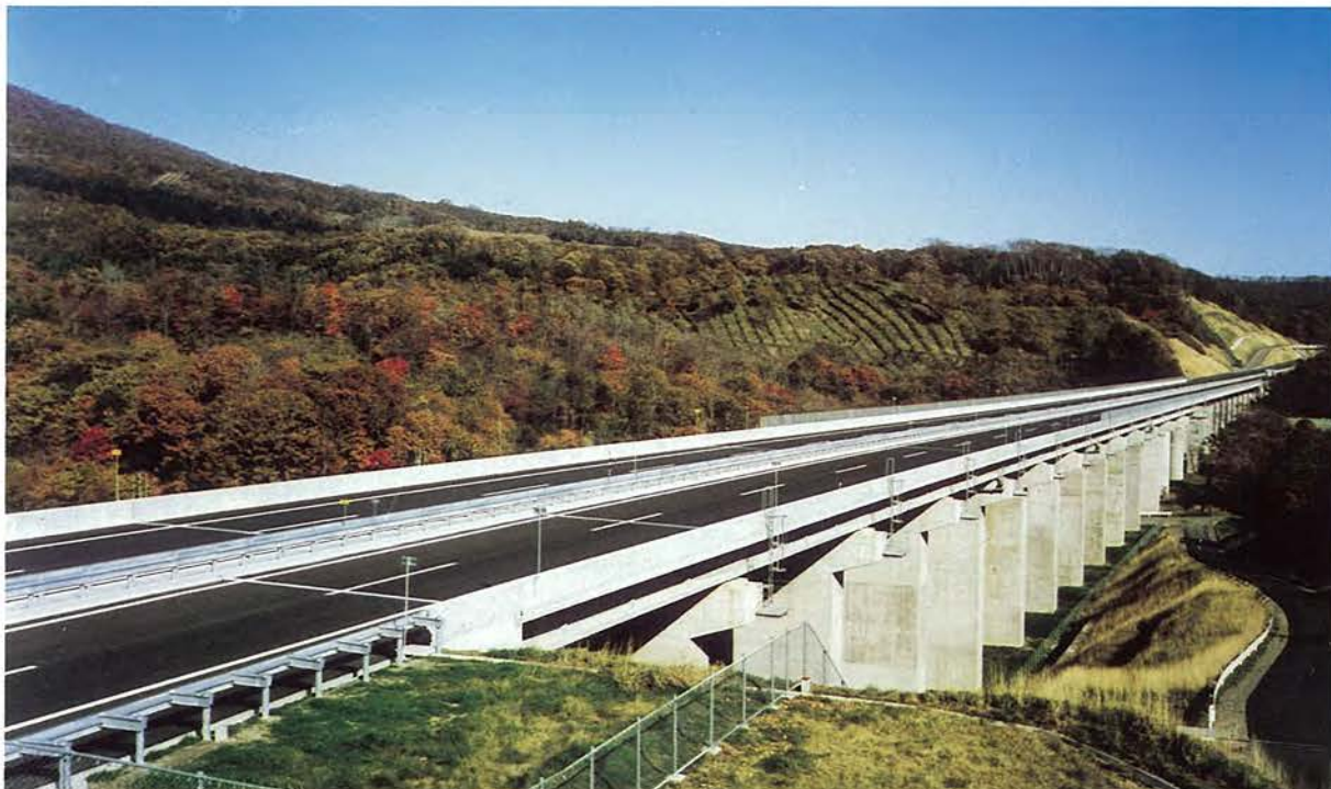
所在地：白老町，橋長：328.45 m，支間割：3 @ 31.20 + (3 @ 22.30) × 3 + 23.00 m，幅員：10.00 m × 2，型式：連続合成桁・連結合成桁・単純合成桁，工法：フレシネー工法，企業者：日本道路公団，施工者：ドービー・川田建設 JV，竣工年：昭和 60 年
