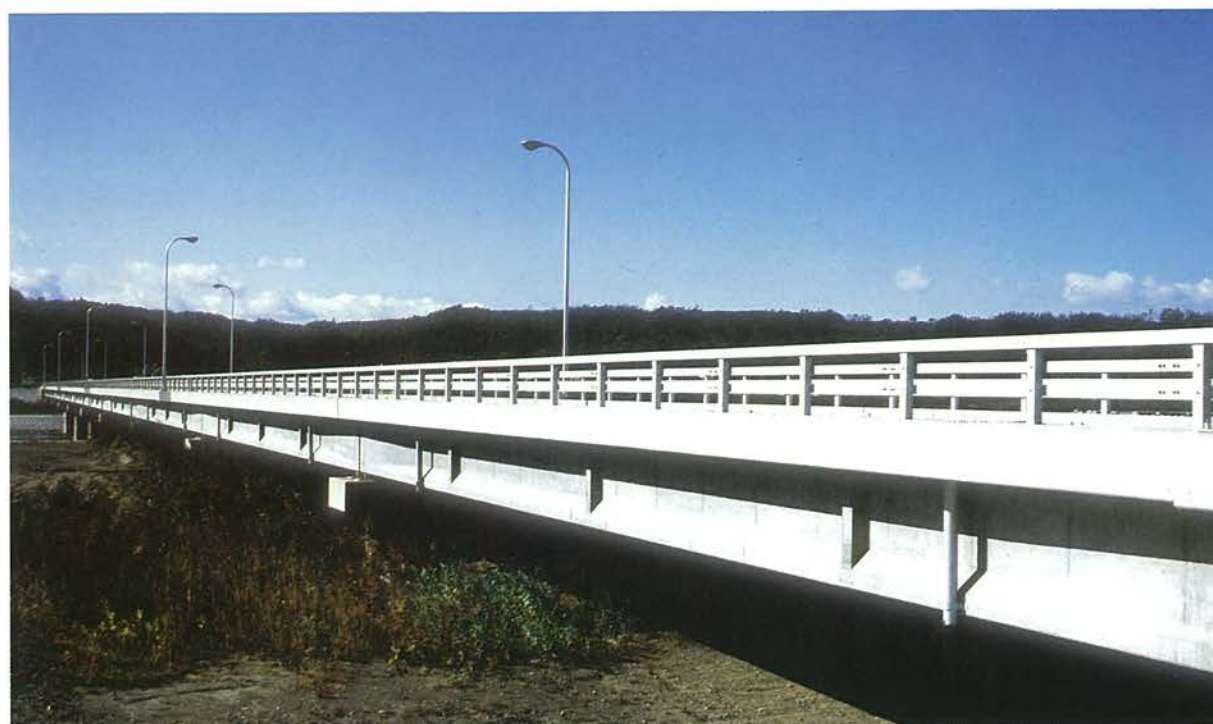
所在地：芽室町，橋長：316.10 m，支間割：10 @ 30.70 m，幅員：7.00 m，型式：単純 T 桁，工法：フレシネー工法， 企業者：十勝支庁，施工者：日本高圧コンクリート，竣功年：昭和 58 年
