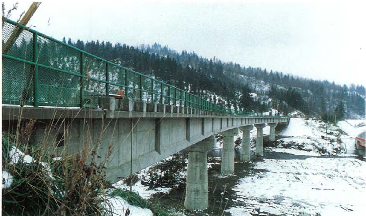
所在地：歌登町，橋長：192.71 m，支間割：6 @ 32.02 m，幅員：3.80 m，型式：単純 T 桁，工法：フレシネー工法， 企業者：日本鉄道建設公団，施工者：ピーエスコンクリート，竣工年：昭和 53 年
