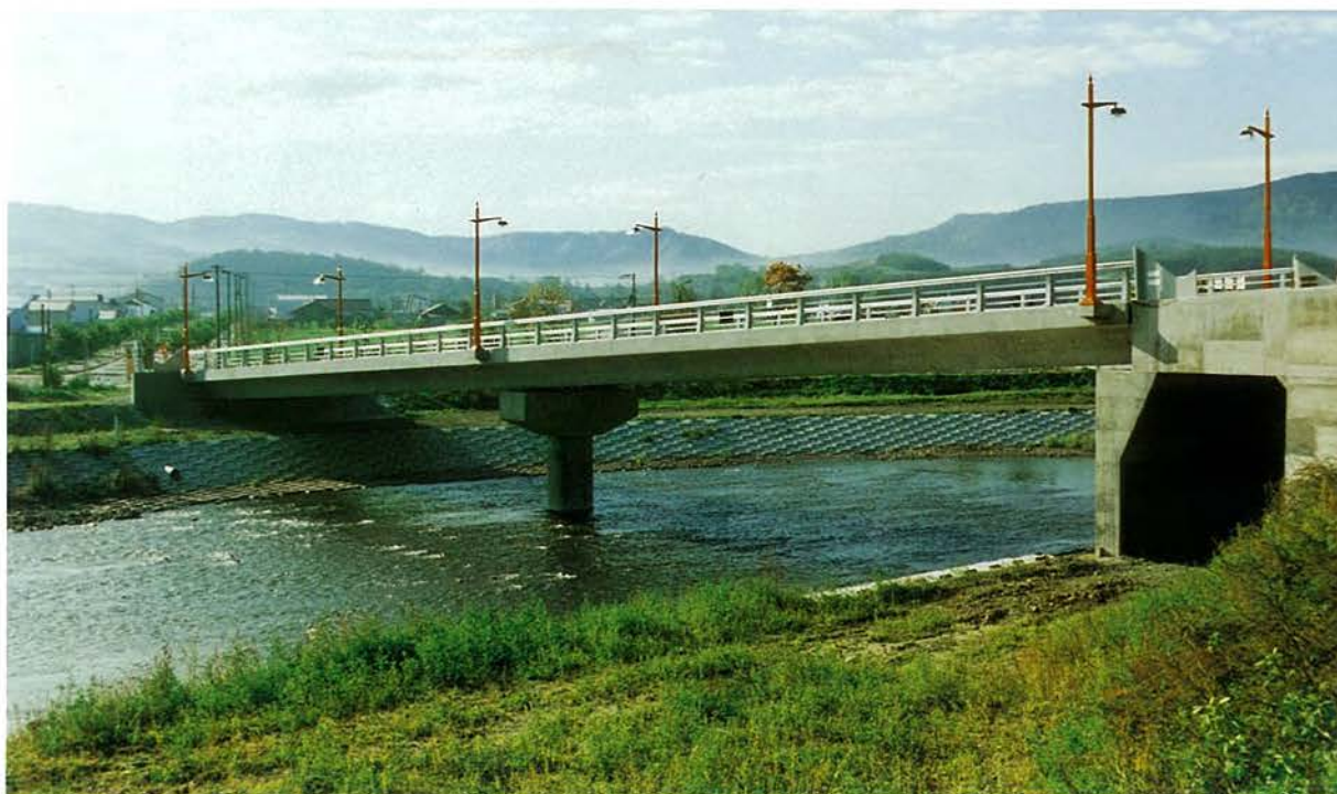
所在地：留辺蘂町，橋長：62.82 m，支間割：2 @ 31.00 m，幅員：8.50 m，型式：2 径間連続中空床版，工法：フレシネー工法，企業者：留辺蘂町，施工者：北海道ピースコンクリート・まるい JV，竣工年：昭和 58 年
