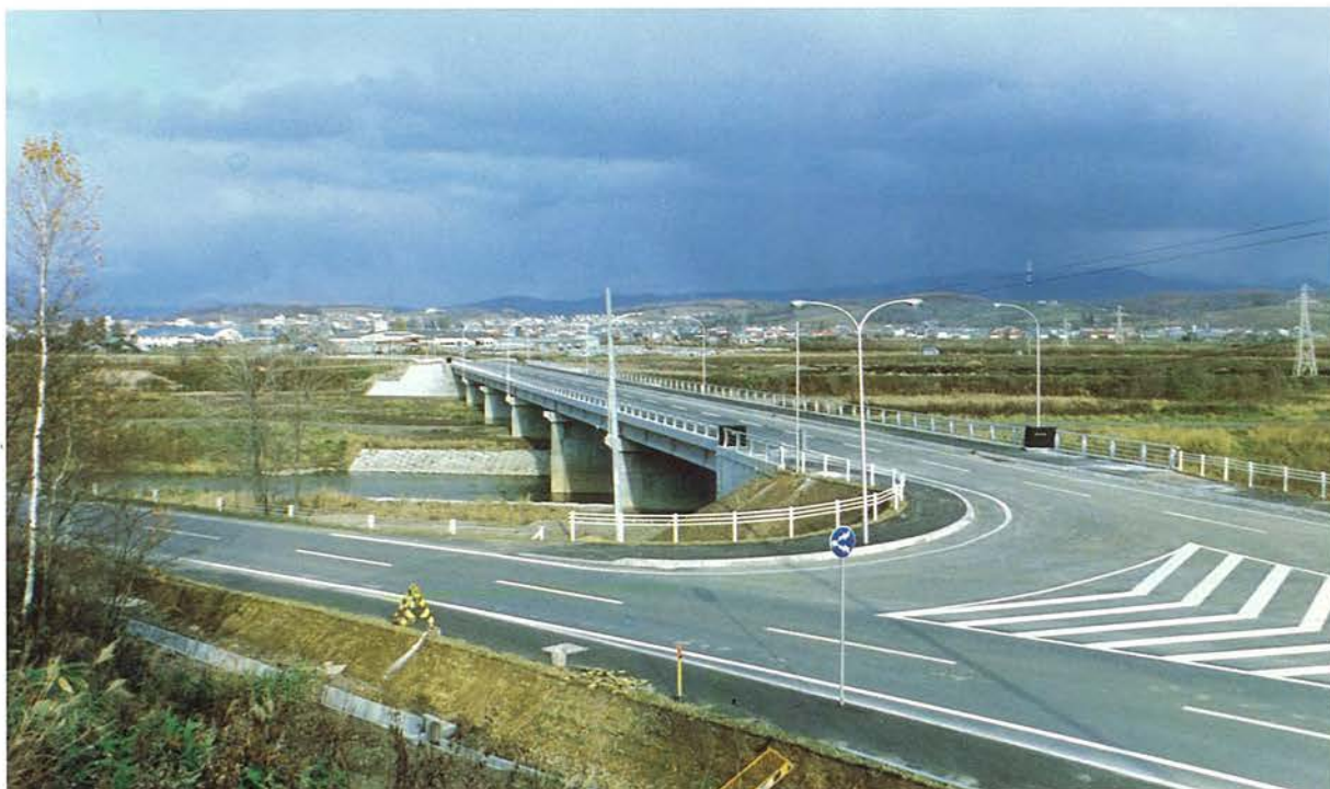
所在地：士別市，橋長：195.40 m，支間割：6 @ 31.75 m，幅員：9.00 + 2 @ 2.50 m，型式：単純 T 桁，工法：フレシネー工法， 企業者：旭川土木現業所，施工者：北海道ビーエスコンクリート，竣功年：昭和 53 年
