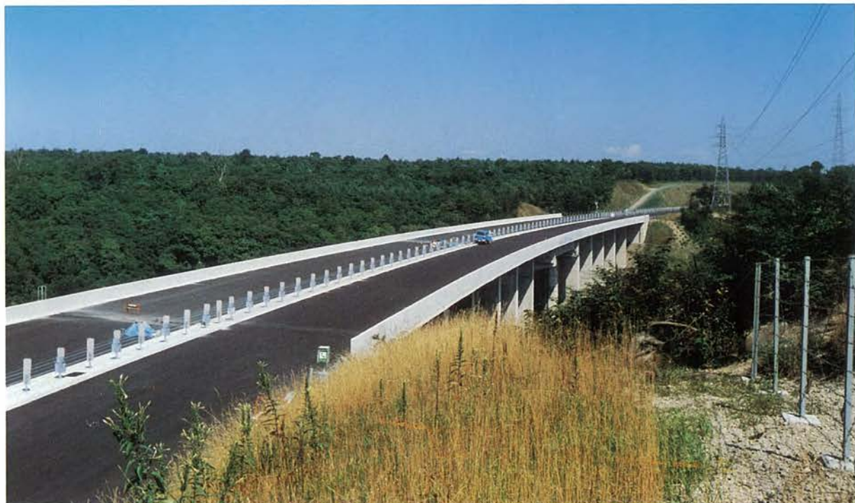
所在地：苫小牧市，橋長：27.50 m，幅員：10.00 m × 2，型式：単純合成桁，工法：フレシネー工法，企業者：日本道路公団，施工者：日本高圧コンクリート，竣工年：昭和 55 年
