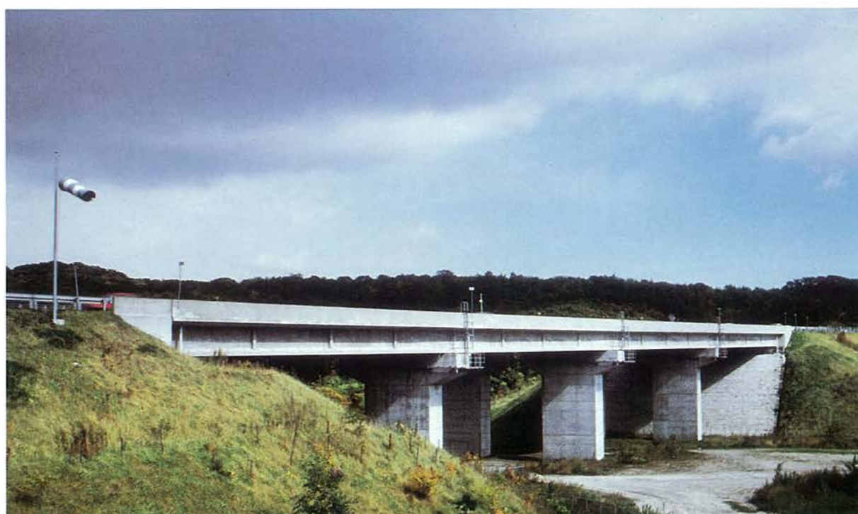
所在地：室蘭市，橋長：61.50 m，支間割：2 @ 30.00 m，幅員：10.50 + 3.00 m，型式：単純 T 桁，工法：BBRV 工法， 企業者：室蘭土木現業所，施工者：北海道ピーエスコンクリート，竣工年：昭和 49 年
