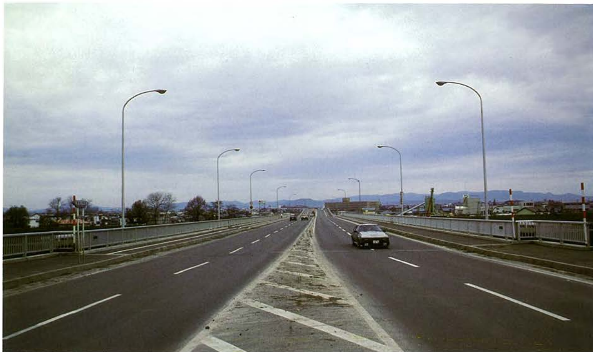
所在地：旭川市，橋長：51.70 m，支間割：3 @ 17.00 m，幅員：17.00 + 2 @ 2.50 m，型式：3 径間連続中空床版，工法：フレシネー工法，企業者：旭川土木現業所，施工者：日本高圧・ピースコンクリート JV，竣工年：昭和 57 年
