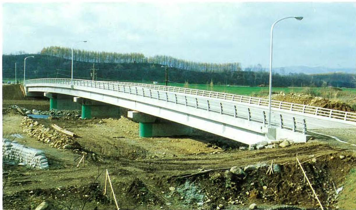
所在地：美瑛町，橋長：127.10 m，支間割：4 @ 31.05 m，幅員：6.75 + 2.00 m，型式：単純 T 桁，工法：フレッシュ工法， 企業者：美瑛町，施工者：北海道ビーエスコンクリート，竣工年：昭和 55 年
