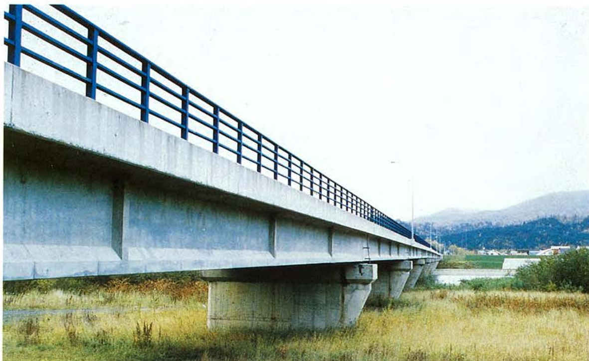
所在地：音威子府町，橋長：346.60 m，支間割：9 @ 38.40 m，幅員：(拡幅) 4.10 m，型式：単純 T 桁，工法：フレシネー工法， 企業者：旭川開発建設部，施工者：オリエンタルコンクリート，竣功年：昭和 56 年
