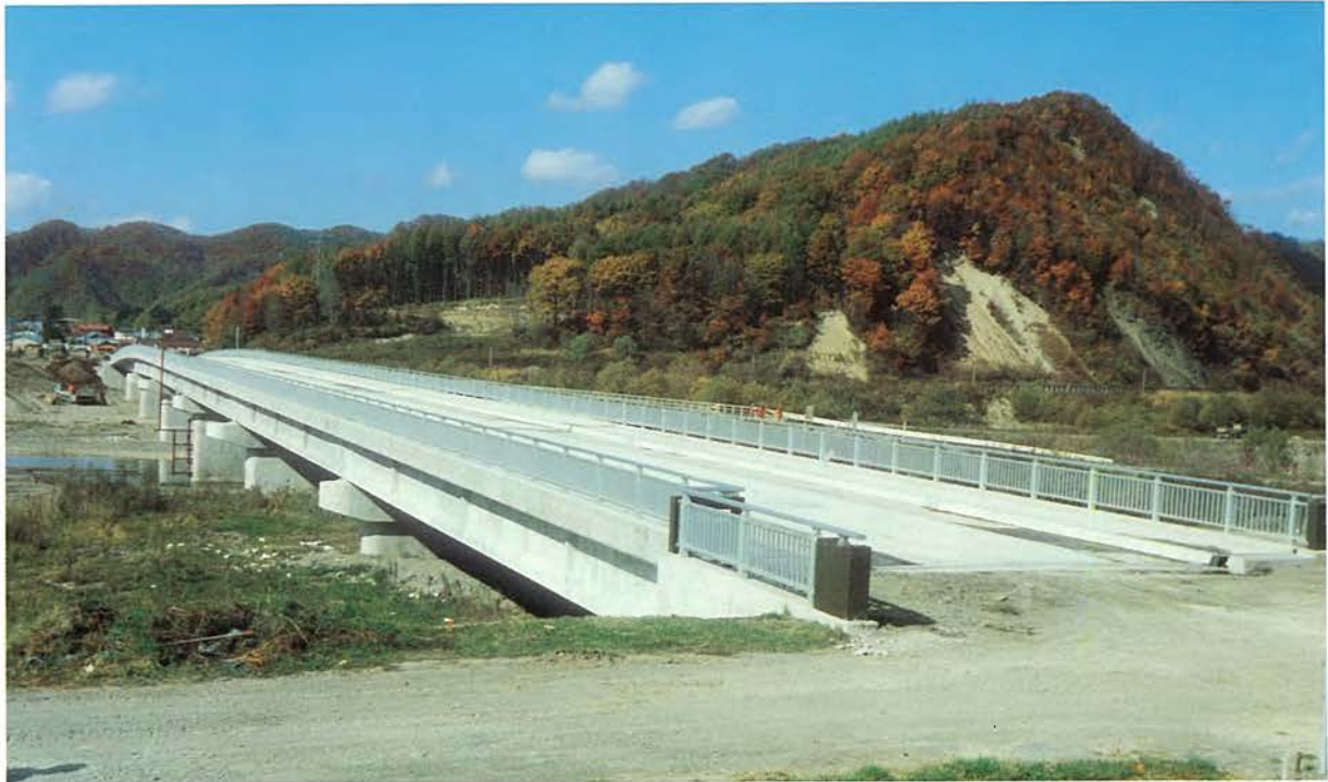
所在地：穂別町，橋長：289.74 m，支間割：5 @ 42.34 + 42.74 + 30.40 m，幅員：2.50 + 7.50 + 2.00 m，型式：単純 T 桁・2 径間連続箱桁，工法：フレシネー工法，企業者：室蘭土木現業所，施工者：北海道ピーエスコンクリート，竣工年：昭和 55 年
