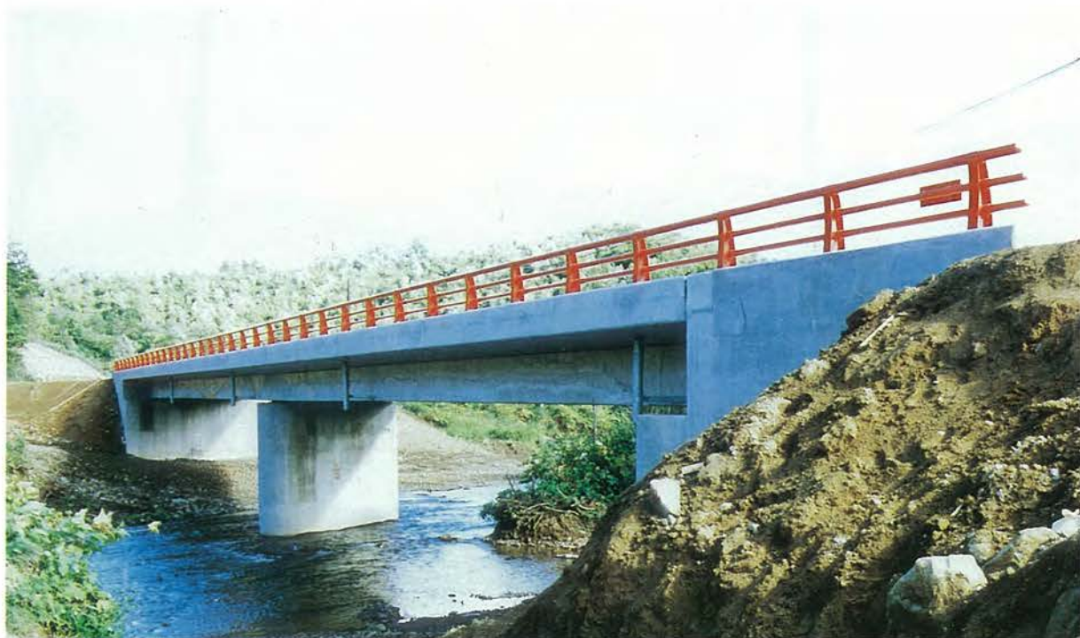
所在地：蘭越町，橋長：60.80 m，支間割：2 @ 29.85 m，幅員：7.50 m，型式：2 径間連続中空床版，工法：フレシネー工法， 企業者：小樽土木現業所，施工者：ピーエスコングリート，竣功年：昭和 59 年
