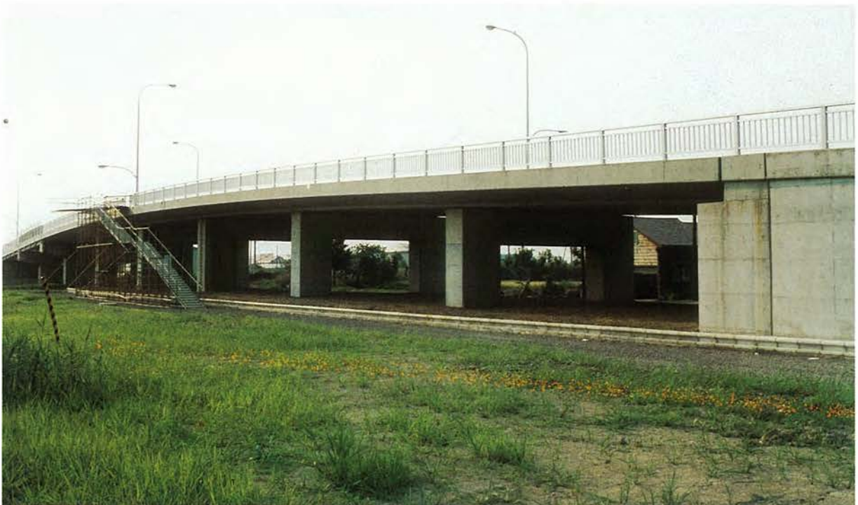
所在地：砂川市，橋長：130.65 m，支間割：8 @ 16.00 m，幅員：8.50 + 2 @ 3.00 m，型式：4 径間連続中空床版， 工法：フレシネー工法，企業者：札幌土木現業所，施工者：北海道ビーエスコンクリート，竣功年：昭和 57 年
