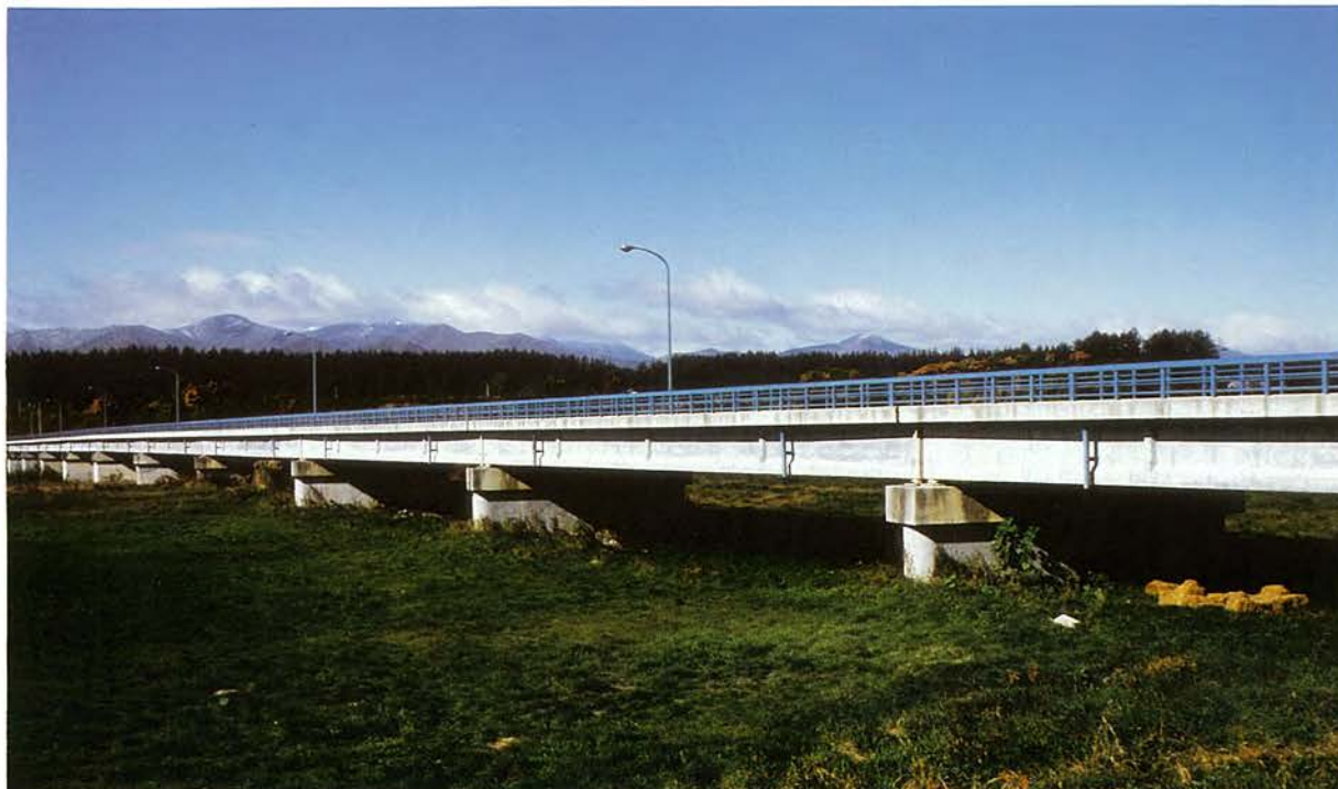
所在地：清水町，橋長：400.00 m，支間割：12 @ 32.62 m，幅員：9.25 m，型式：単純 T 桁，工法：フレシネー工法， 企業者：帯広土木現業所，施工者：日本高圧コンクリート，竣功年：昭和 51 年
