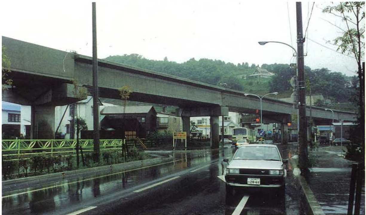
所在地：網走市，橋長：61.65 m，支間割：2 @ 30.00 m，幅員：8.00 m，型式：単純下路桁，工法：フレシネー工法， 企業者：旭川鉄道管理局，施工者：ドービー建設工業，竣功年：昭和 59 年
