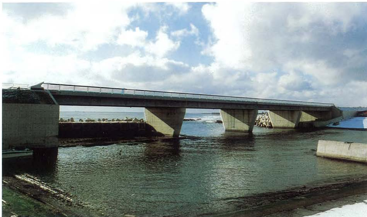
所在地：松前町，橋長：125.00 m，支間割：4 @ 30.50 m，幅員：9.50 + 2.50 + 1.50 m，型式：単純 T 桁，工法：フレシネー工法， 企業者：函館開発建設部，施工者：日本高圧コンクリート，竣功年：昭和 54 年
