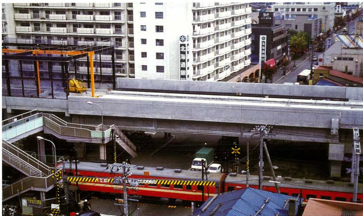
所在地：札幌市，橋長：37.00 m，幅員：16.60 m，型式：単純T桁，工法：フレシネー工法，企業者：札幌工事局， 施工者：日本高圧コンクリート，竣工年：昭和61年
