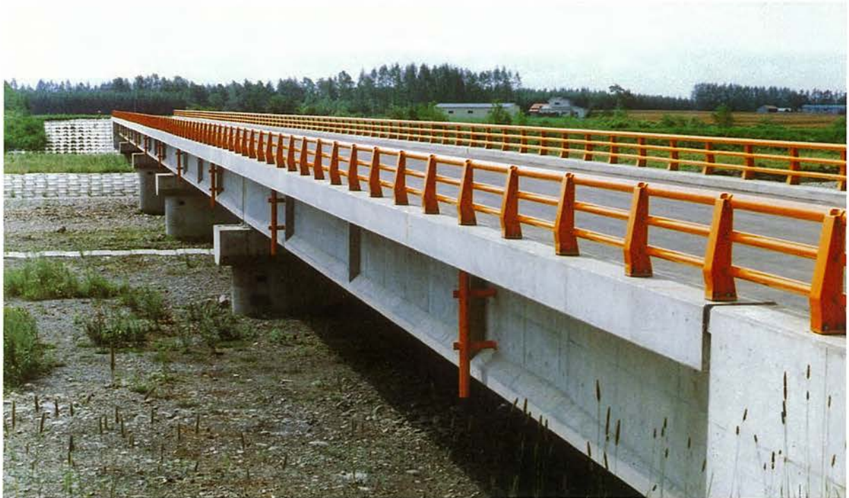
所在地：士幌町，橋長：196.20 m，支間割：5 @ 38.50 m，幅員：7.50 m，型式：単純 T 桁，工法：フレシネー工法， 企業者：士幌町，施工者：北海道ビーエスコンクリート，竣功年：昭和 57 年
