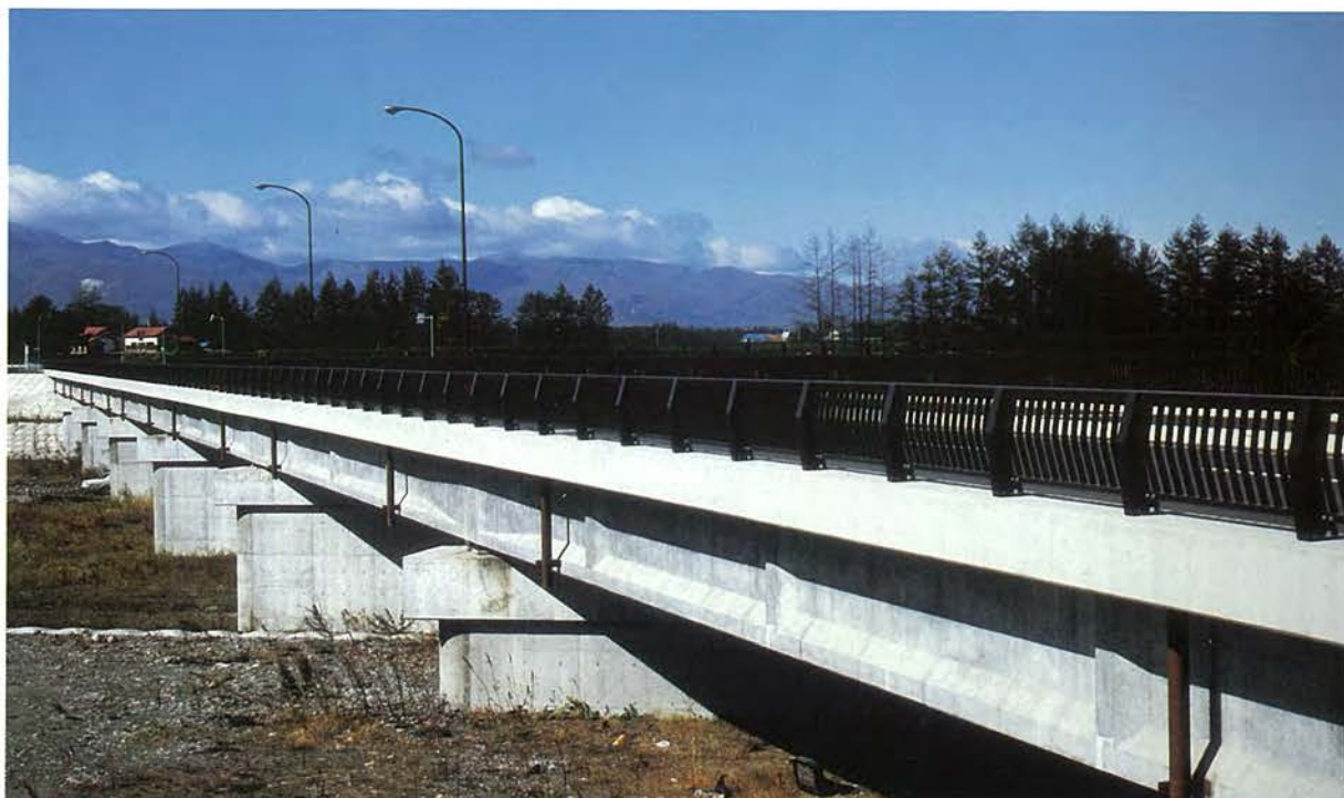
所在地：芽室町，橋長：205.50 m，支間割：7 @ 28.60 m，幅員：7.50 + 2.00 m，型式：単純 T 桁，工法：フレッシュ工法， 企業者：芽室町，施工者：日本高圧コンクリート，竣功年：昭和 59 年
