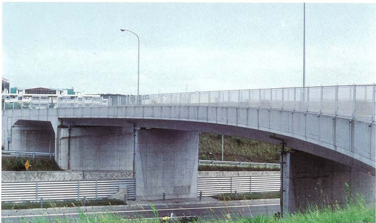
所在地：札幌市，橋長：63.40 m，支間割：18.55 + 29.50 + 14.45 m，幅員：8.50 m，型式：3 径間連続中空床版， 工法：フレシネー工法，企業者：札幌開発建設部，施工者：住友建設，竣功年：昭和 55 年
