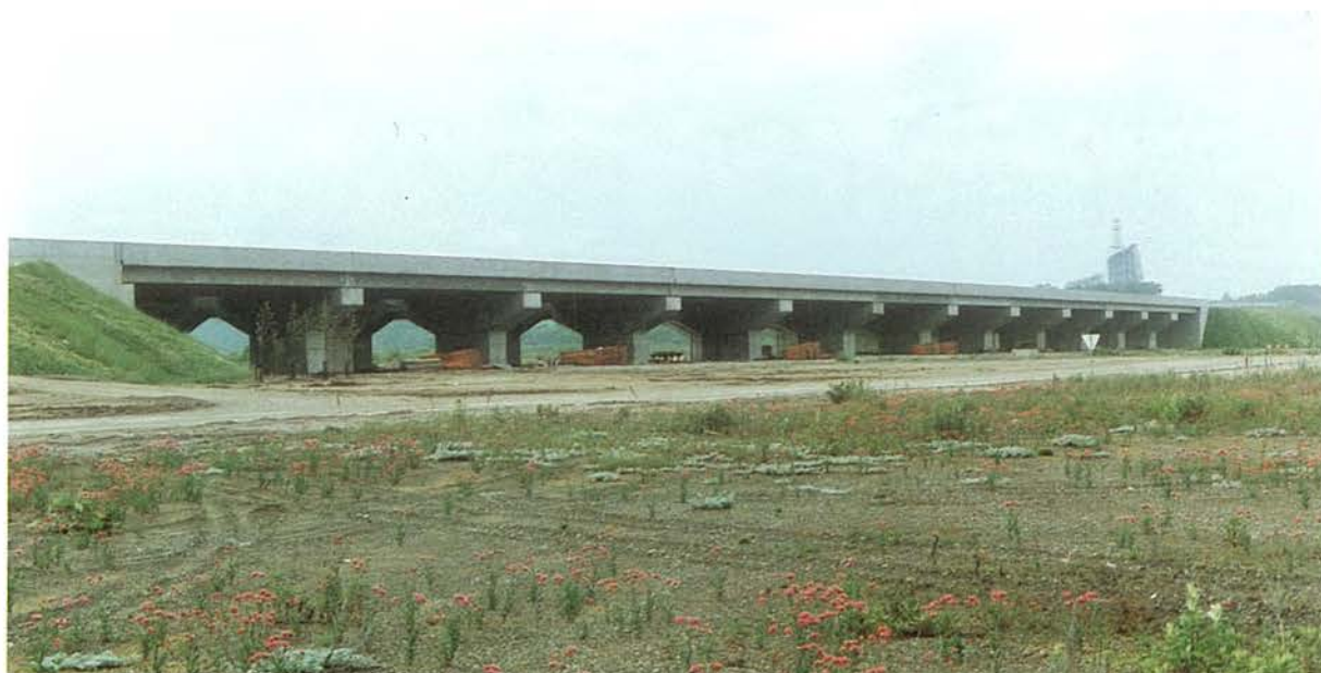
所在地：苫小牧市，橋長：262.68 m，支間割：12 @ 21.10 m，幅員：10.00 × 2 m，型式：3 径間連結桁，工法：フレッシュー工法， 企業者：日本道路公団，施工者：北海道ビーエスコンクリート，竣功年：昭和 54 年
