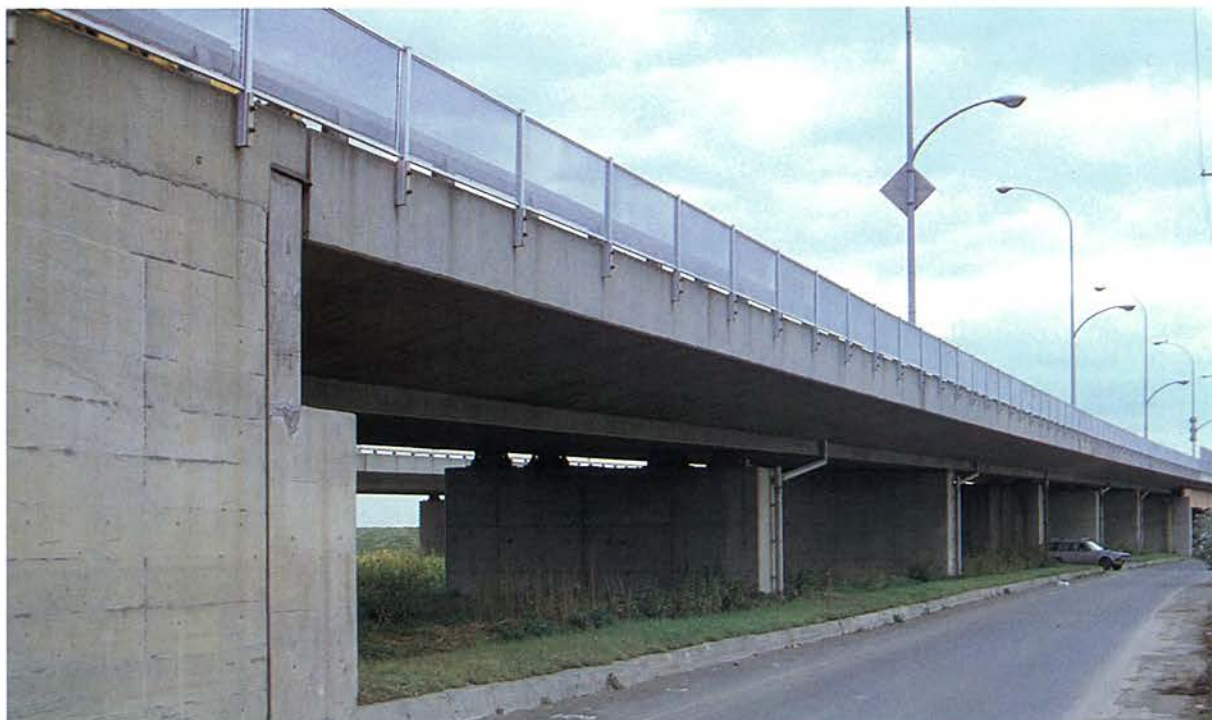
所在地：札幌市，橋長：275.46 m，支間割：12 @ 22.75 m，幅員：8.00 + 2.00 m，型式：3 径間連続中空床版， 工法：フレッシュ工法，企業者：札幌開発建設部，施工者：日本高圧コンクリート，竣工年：昭和 49 年
