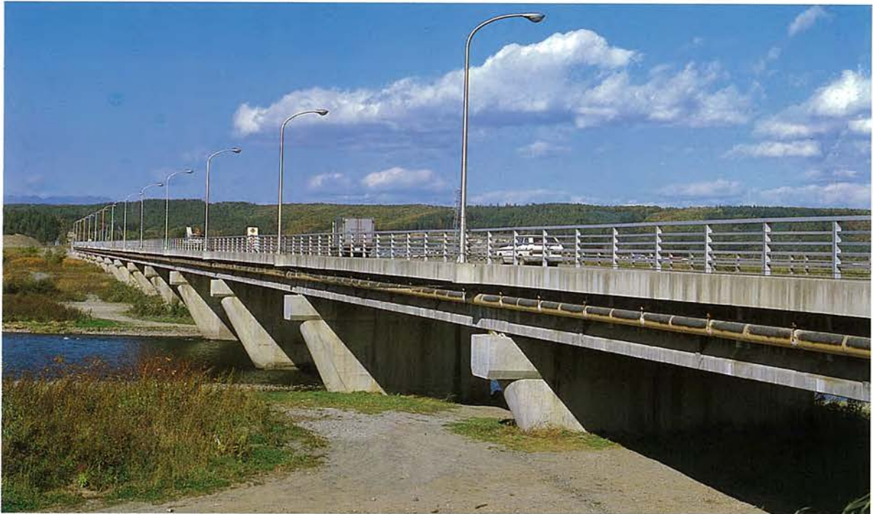
所在地：帯広市，橋長：492.00 m，支間割：14 @ 34.30 m，幅員：(拡幅) 8.00 + 2.50 m，型式：単純 T 桁， 工法：フレシネー工法，企業者：帯広土木現業所，施工者：日本高圧コンクリート，竣功年：昭和 55 年
