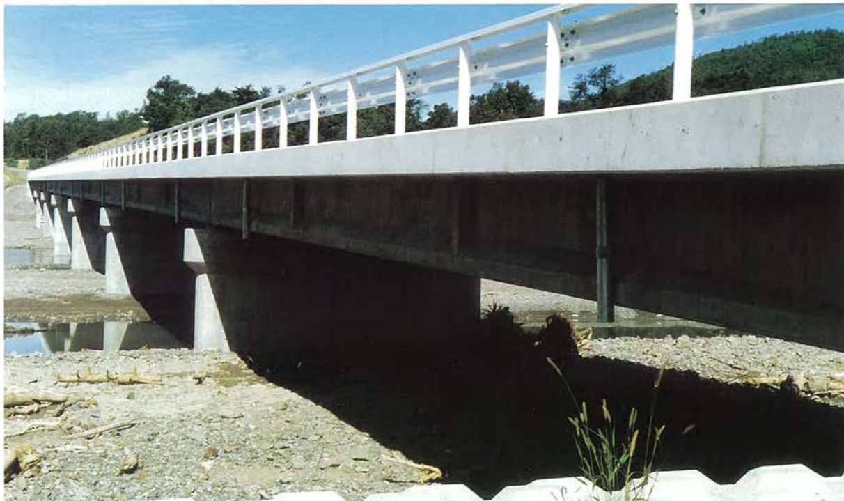
所在地：浦河町，橋長：183.30 m，支間割：7 @ 25.70 m，幅員：7.50 m，型式：単純 T 桁，工法：フレッシュ工法， 企業者：室蘭開発建設部，施工者：ピーエスコンクリート，竣工年：昭和 52 年
