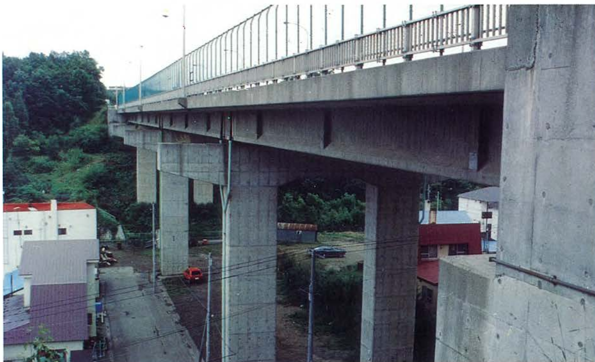
所在地：札幌市，橋長：143.00 m，支間割：2 @ 36.20 + 2 @ 33.00 m，幅員：(拡幅) 3.50 m，型式：単純 T 桁， 工法：BBRV 工法，企業者：札幌市，施工者：北海道ピーエスコンクリート，竣工年：昭和 54 年
