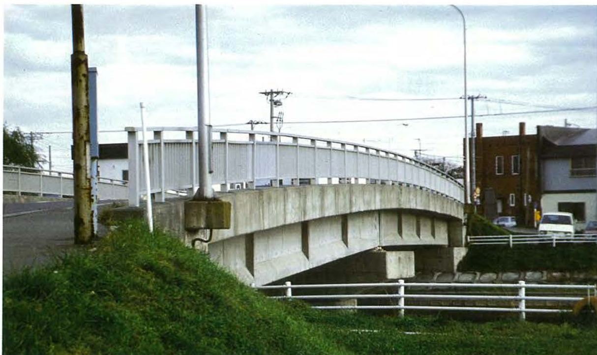
所在地：千歳市，橋長：58.10 m，支間割：2 @ 28.30 m，幅員：9.00 + 2 @ 2.25 m，型式：単純 T 桁，工法：フレシネー工法， 企業者：千歳市，施工者：日本高圧コンクリート，竣功年：昭和 53 年
