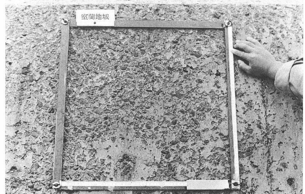
写真5 防波堤 (胸壁側面、D = 2.64mm)
