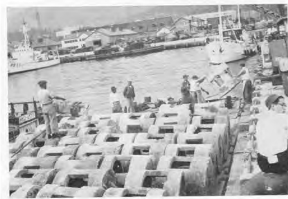
図-3 円筒型(1m)魚礁の舁への積込
