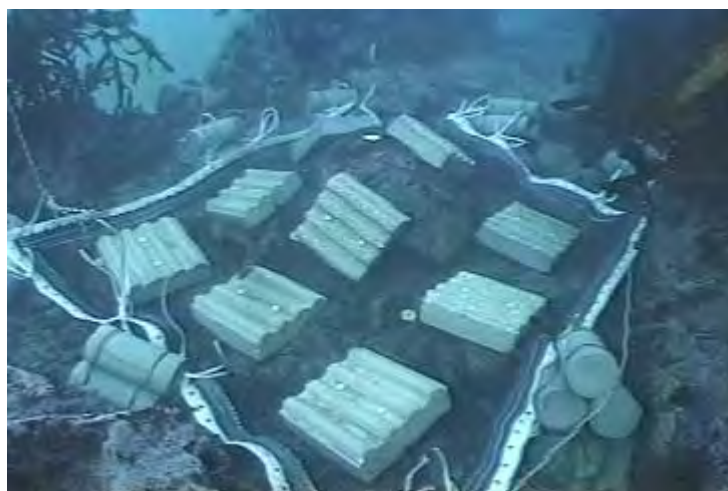
図 3-5 海底への敷設状況
