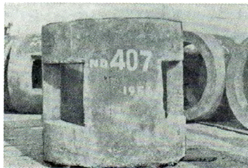
写真 1-1 開発当初の 1m 円筒型魚礁ブロック
