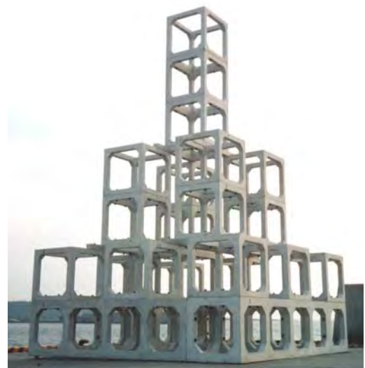
写真 1-2 組み立て魚礁（ピラミッド型） 高さ：10.8m 容積：209.91 空 \text{m}^3
