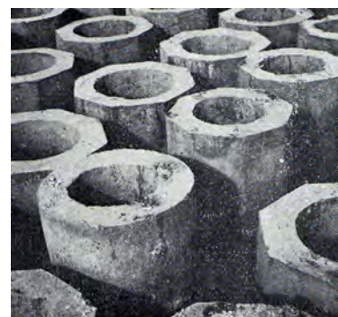
写真 1-4 コンブ着生用 八角型・円型コンクリートブロック
