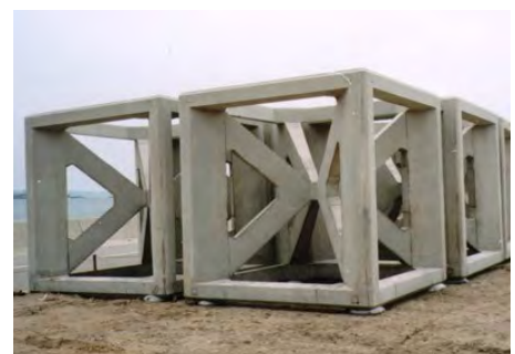
写真 1-3 FP 魚礁（3.00 型） 高さ：3.00m 容積：27.0 空 \text{m}^3
