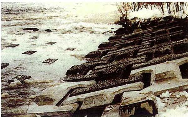
写真 3.4.1 設置直後のポーラスコンクリートブロック(平成7年)
