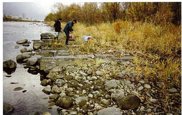
写真 3.4.2 8年経過後のポーラスコンクリートブロック(平成15年11月)
