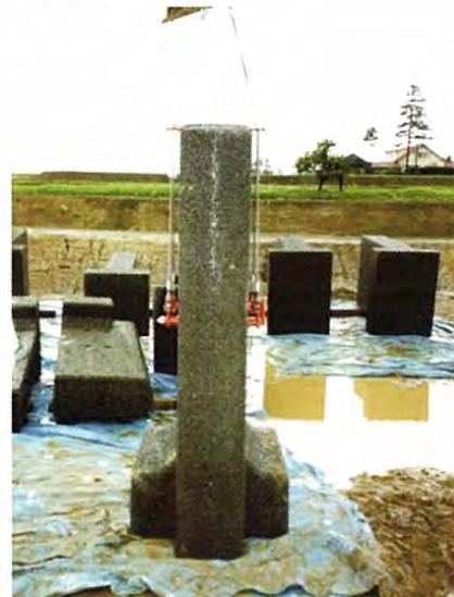
写真 5.2.1 ポーラスコンクリート床止工
