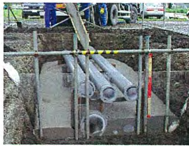
写真-4.2 CLSM 打設状況(2)
