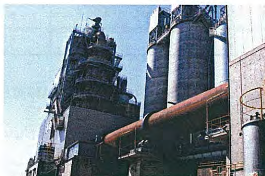
写真1. エコセメントプラント
