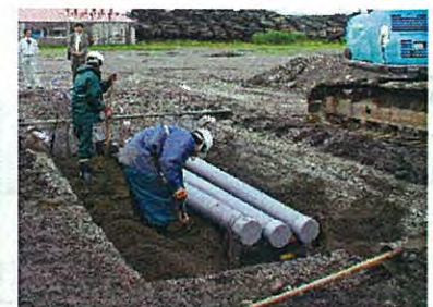
写真-4.6 砂の敷均し
