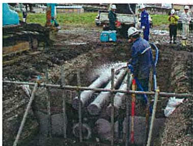
写真-4.7 砂の水締め
