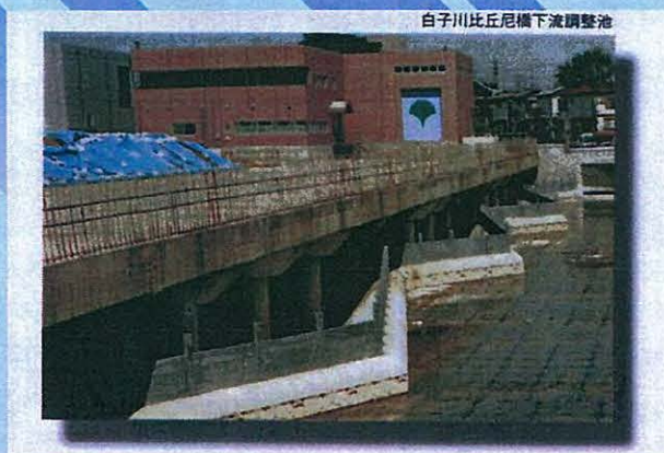
写真4. 東京都白子川比丘尼橋下流調節池
