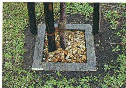
写真 5-11 完了（エコポット埋設深 40 cm）
