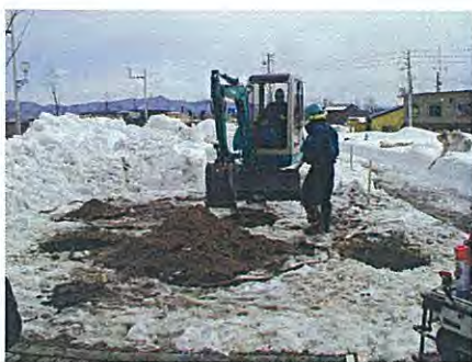
写真 5-2 植穴掘削状況
