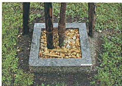
写真 5-12 完了（エコポット埋設深 25 cm）
