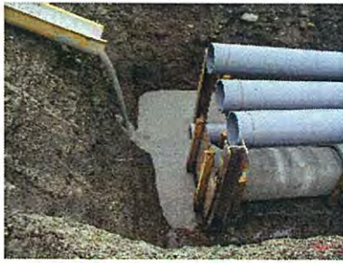
写真-4.1 CLSM 打設状況(1)
