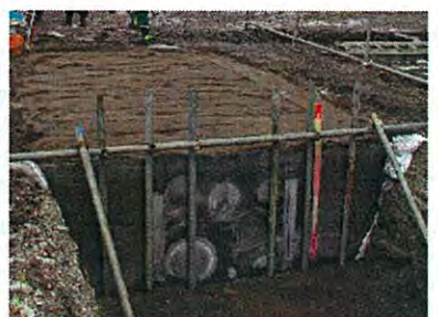
写真-4.9 砂の埋戻し完了
