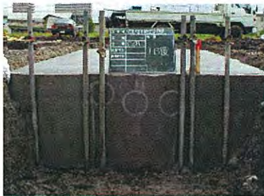
写真-4.4 CLSM 打設完了断面
