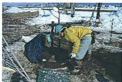
写真 5-8 支柱建込状況
