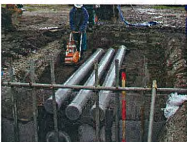
写真-4.8 砂の転圧
