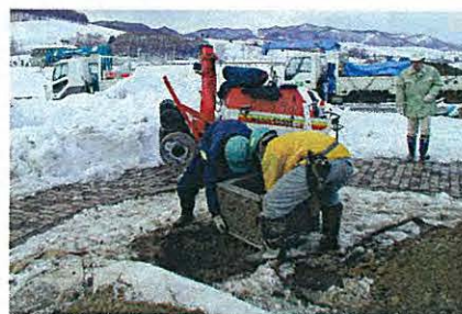
写真 5-5 エコポット据付状況
