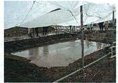
写真-4.3 CLSM 打設完了
