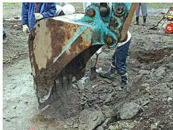
写真-4.11 CLSM 掘削状況
