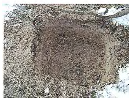
写真 5-3 植穴掘削後状態
