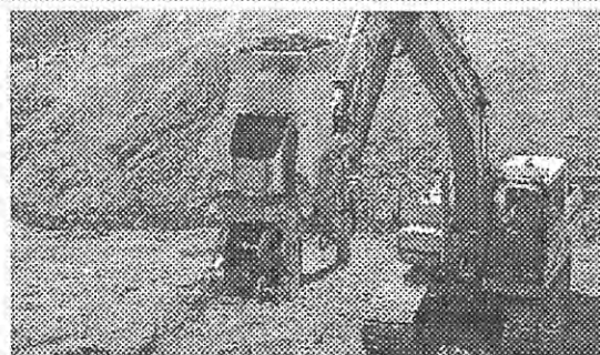
バックホウ(0.7m 3 級)＋高速ベルコン式敷きだし装置
