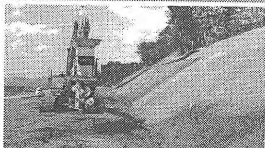
高速バレーコンの吐出角度を45度回転させた状態で施工 （作業エリアをあまり占有できない場合）
