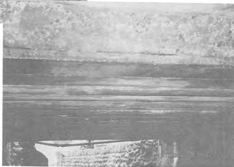
Photo2.1.3.15 調査対象構造物N0.15の写真
