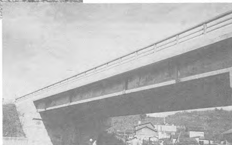
Photo2.1.3.3 調査対象構造物N0.3の写真
