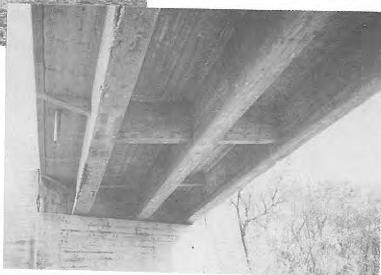
Photo2.1.3.19 調査対象構造物N0.19の写真
