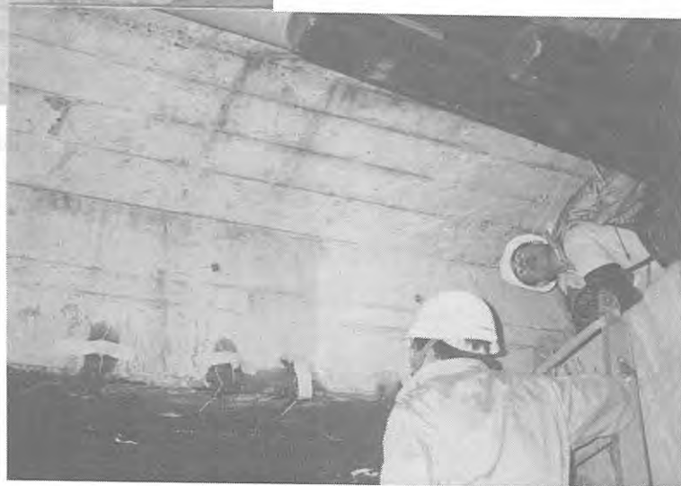
Photo2.1.3.9 調査対象構造物N0.9の写真
