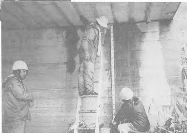
Photo2.1.3.16 調査対象構造物N0.16の写真
