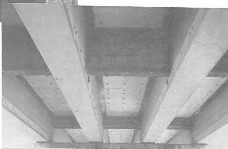
Photo2.1.3.4 調査対象構造物N0.4の写真
