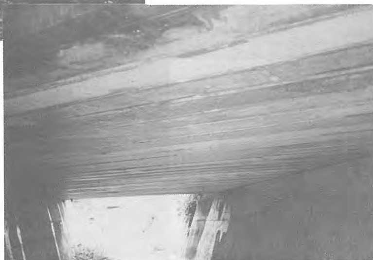
Photo2.1.3.17 調査対象構造物N0.17の写真
