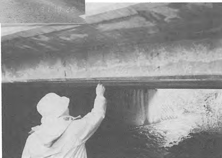
Photo2.1.3.18 調査対象構造物N0.18の写真
