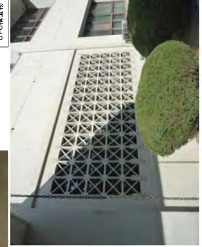
写真の事例は、既存建物の内部や外壁部に後施工で設置したUFC耐震壁の事例である
