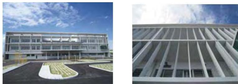
写真－2.1.2 UFC 意匠部材の例（警察運転免許センター：沖縄県）
