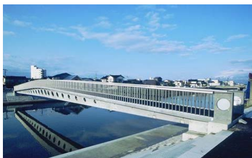
写真－2.1.1 UFC 構造物の例（酒田みらい橋：山形県）
