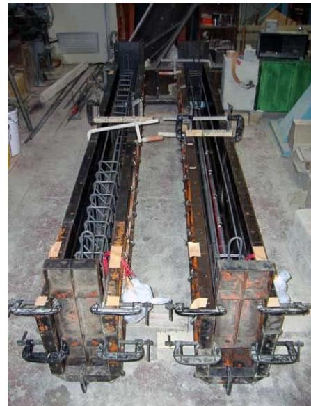
写真3.3.2 型枠への設置
