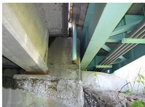
写一解 2.4.12 排水管の流末処理不足による橋台の変状例
