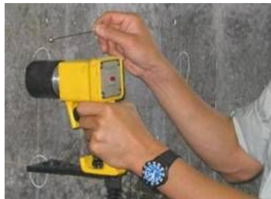
写真一解 2.1.8 弾性衝撃波法の測定状況 4)
