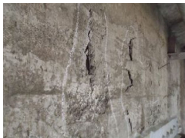
写一解 2.3.17 中性化 (鉄筋露出)
