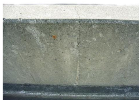
写一解 2.4.1 初期欠陥による劣化状況（ひび割れ）
