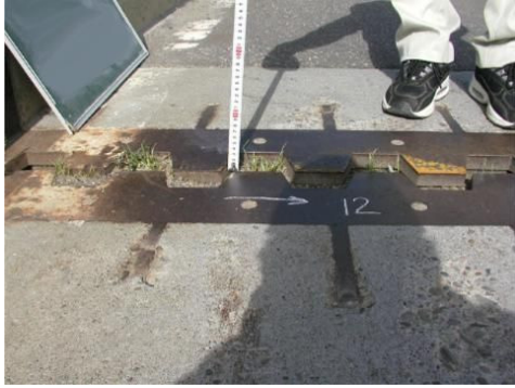
写一解 2.4.7 路面凹凸の例
