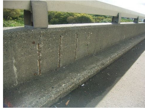
写一解 2.4.4 中性化による劣化状況の例
