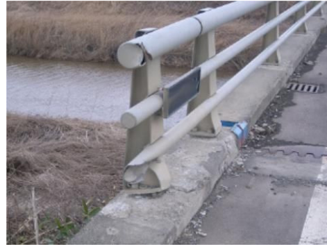
写一解 2.4.2 防護柵付近の変状の例
