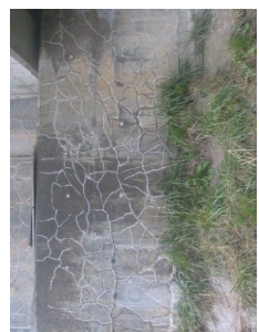
写真c-2(2) アルカリシリカ反応 (壁、沓座付近)
