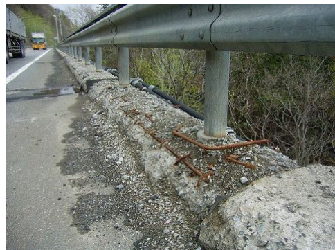
写一解 2.4.3 凍害による劣化状況の例
