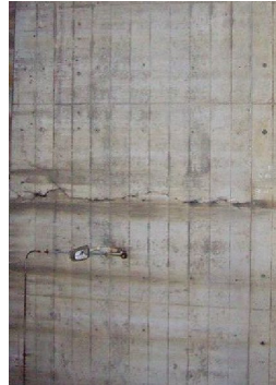
写真a-1(2) 鉛直ひび割れの例 (橋台縦壁)
