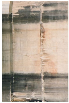
写真a-1(2) 鉛直ひび割れの例 (橋台縦壁)
