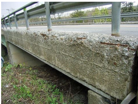
写一解 2.4.3 凍害による劣化状況の例
