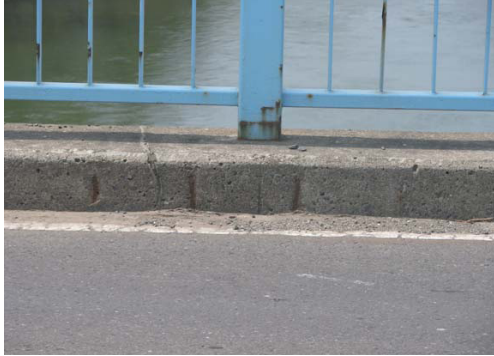
写一解 2.4.4 中性化による劣化状況の例
