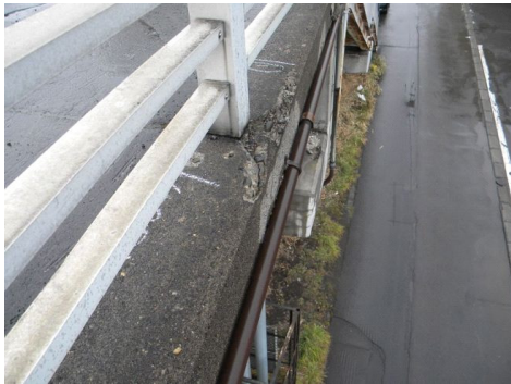
写一解 2.4.2 防護柵付近の変状の例
