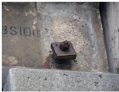
写一解 2.1.2 横締め PC 鋼材の突出
