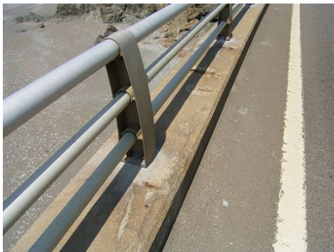
写一解 2.4.5 塩害による劣化状況の例
