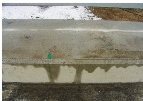
写一解 2.4.1 初期欠陥による劣化状況（ひび割れ）
