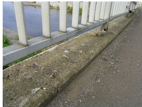
写一解 2.4.5 塩害による劣化状況の例
