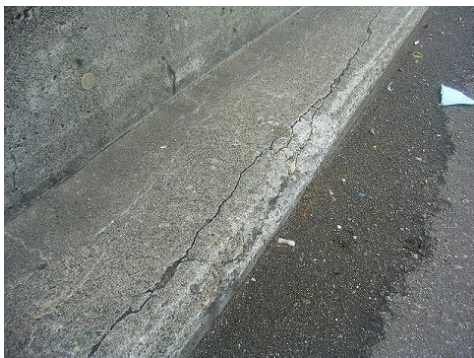
写一解 2.4.6 アルカリシリカ反応による劣化状況の例
