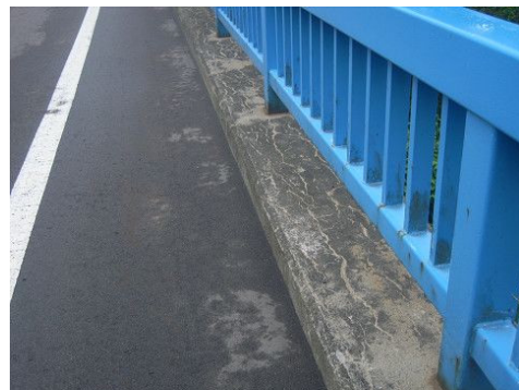
写一解 2.4.6 アルカリシリカ反応による劣化状況の例
