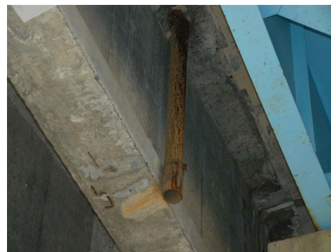
写一解 2.4.11 排水管の流末処理不足による主桁の変状例
