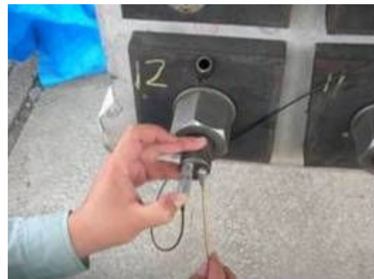
写真一解 2.1.7 打音振動法の測定状況 4)
