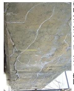
写真c-2(3) アルカリシリカ反応 (上梁正面)
