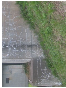
写真c-2(3) アルカリシリカ反応 (壁、翼壁)
