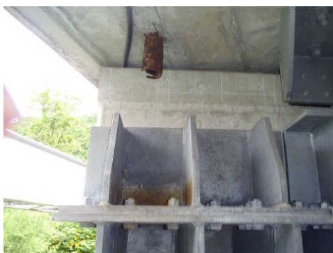
写一解 2.4.10 排水管の流末処理不足による落橋防止装置への水かかりの例
