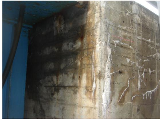
写一解 2.2 凍害によるひび割れ
