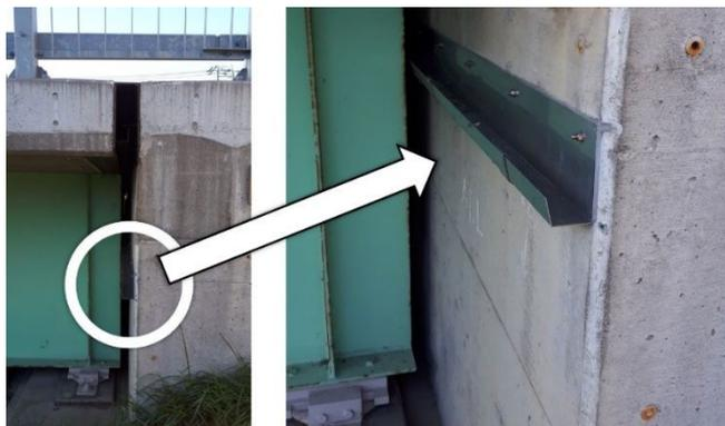
写真 7.1 伸縮装置直下への樋の設置例（伸縮装置からの再漏水に備えた多重防護対策）
